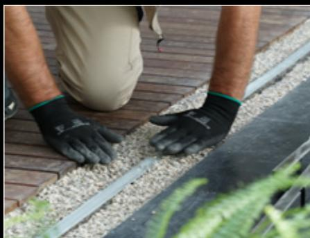
Для наружного применения необходимо обеспечить гравий или щебень минимум на дополнительные 300 мм к светильнику или же подходящую систему водоотвода.
